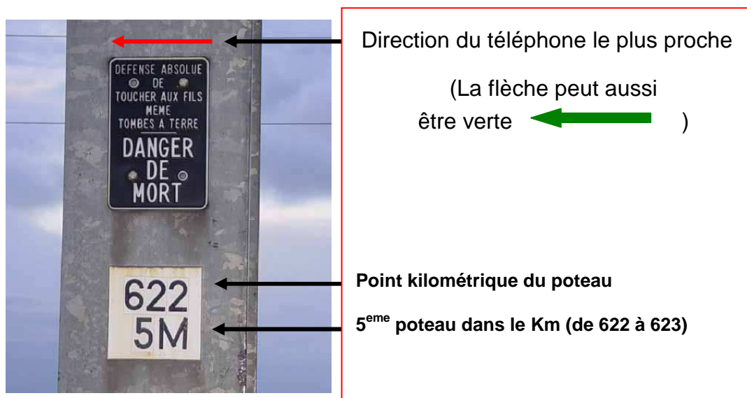
Localisation en ligne et position du téléphone d'alarme le plus proche
